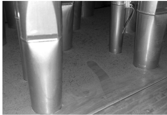
Reinigung mit Stahlwolle
